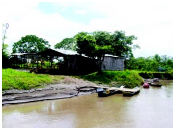
Puerto La Banqueta, donde se construirá el Puerto Fluvial Internacional. Octubre 20/06. Foto. FTFDO
